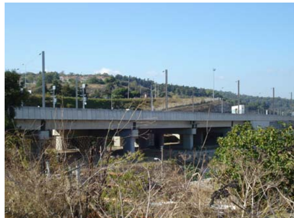
Figura 3.6 Zona de acessos à ponte na margem norte
