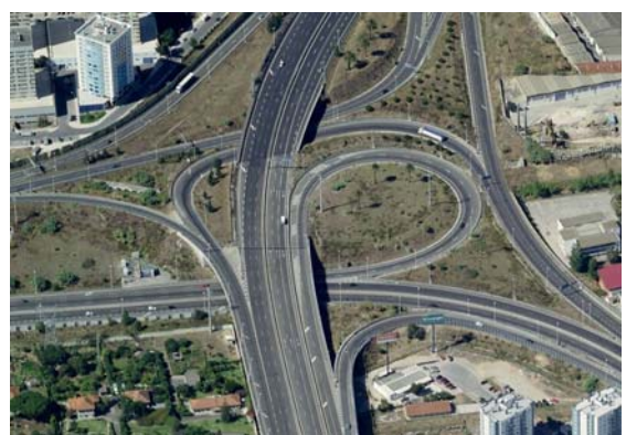
Figura 3.11 Zona de acessos à ponte na margem norte
