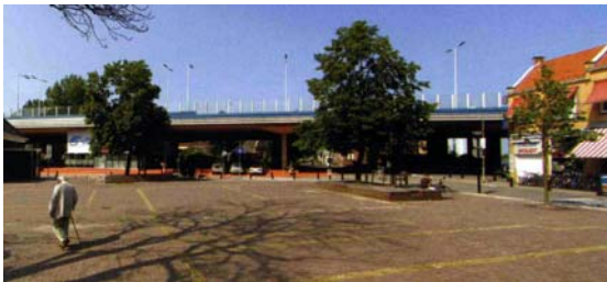
Figura 3.13 Viaduto visto da praça da Câmara Municipal
