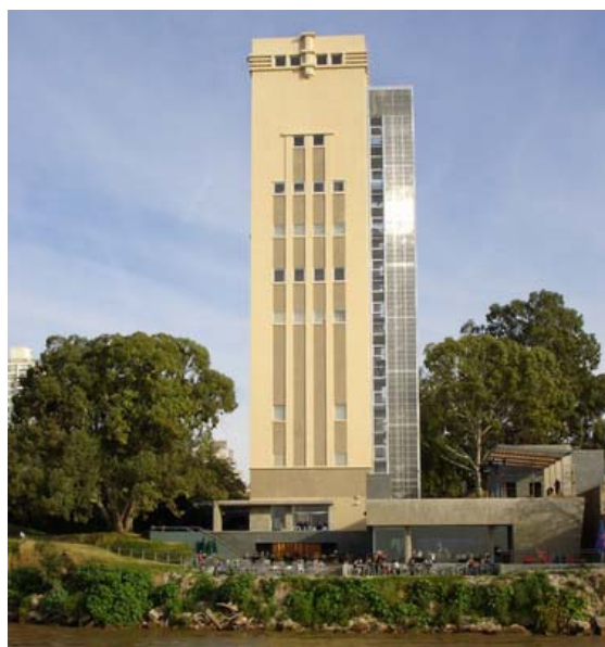
Figura 3.38 Fachada norte do silo
