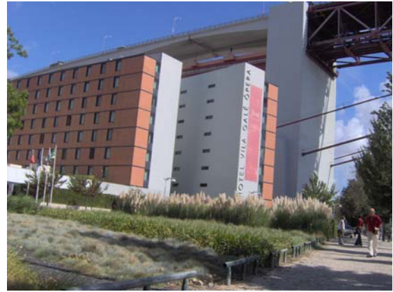
Figura 3.2 Hotel Vila Galé Ópera e os maciços da ponte
