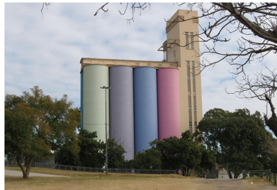
Figura 3.37 Silo Davis a nascente
