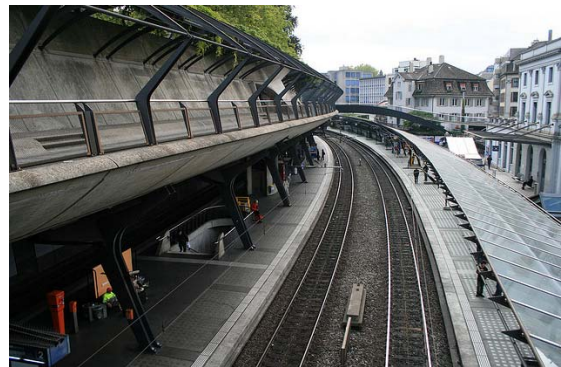
Figura 3.20 Estação vista da ponte rodoviária
