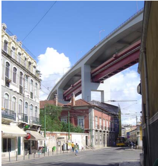
Figura 3.3 Ponte vista da Rua 1 de Maio
