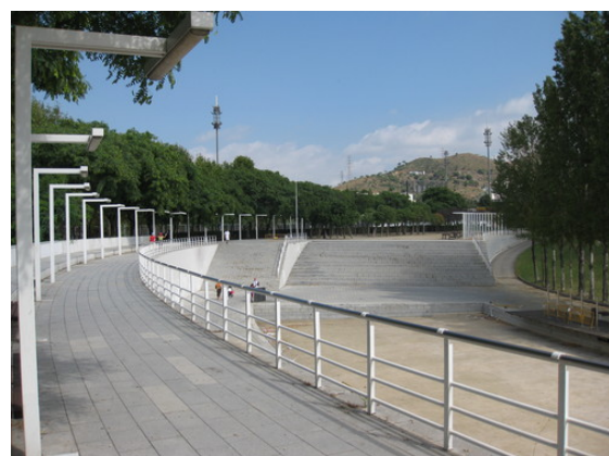
Figura 3.31 Vista do patamar superior à entrada
